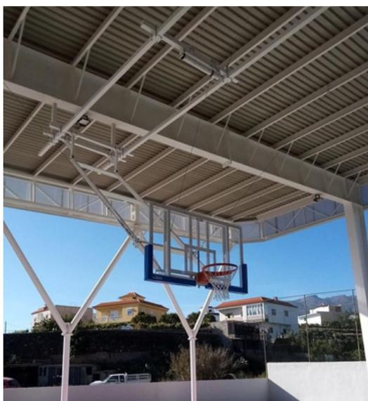
**CANASTAS BALONCESTO:** al techo multitubo y elevación mediante motor.
