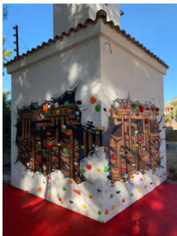
Rocódromo de presas sobre pared. Texturado y pintado con pintura de doble componente, certificado de ingeniería y de construcción según normativa UNE-EN12572
